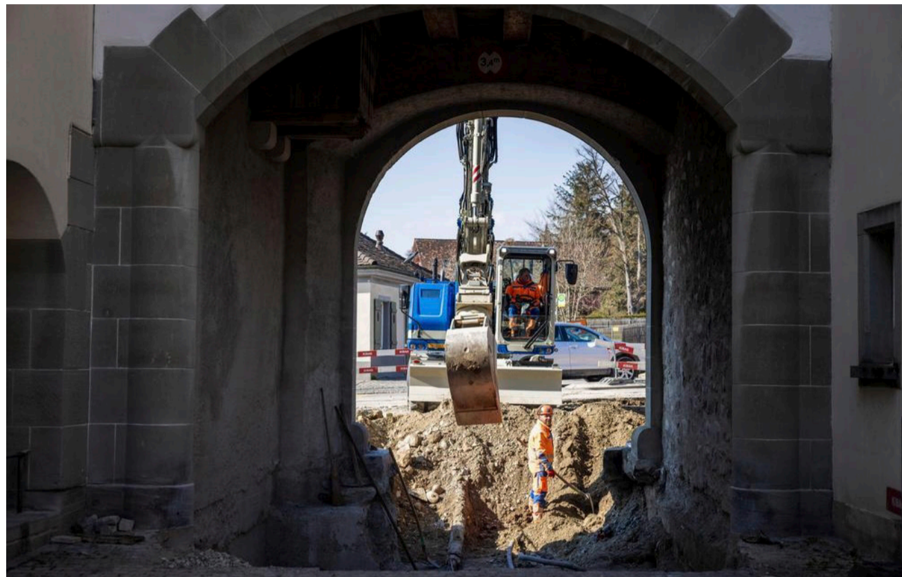
Die Arbeiten am Untertor in Stein am Rhein starteten Anfang Februar.
