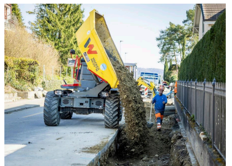
Auch an der Öhningerstrasse hat die bestehende Leitung ihre Lebensdauer erreicht und muss ausgetauscht werden.
