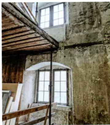
Das Zeughaus wird gelegentlich als Lagerraum verwendet.
