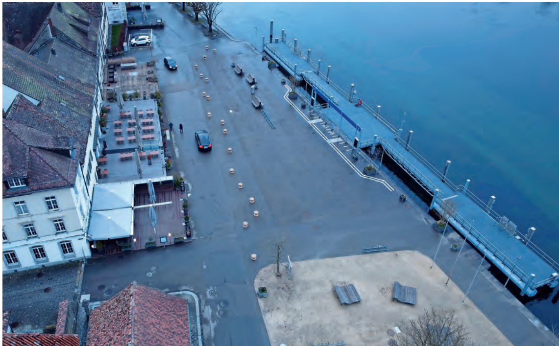
Der westliche Teil der Schifflände mit der Strasse und den Terrassen auf Podesten.
