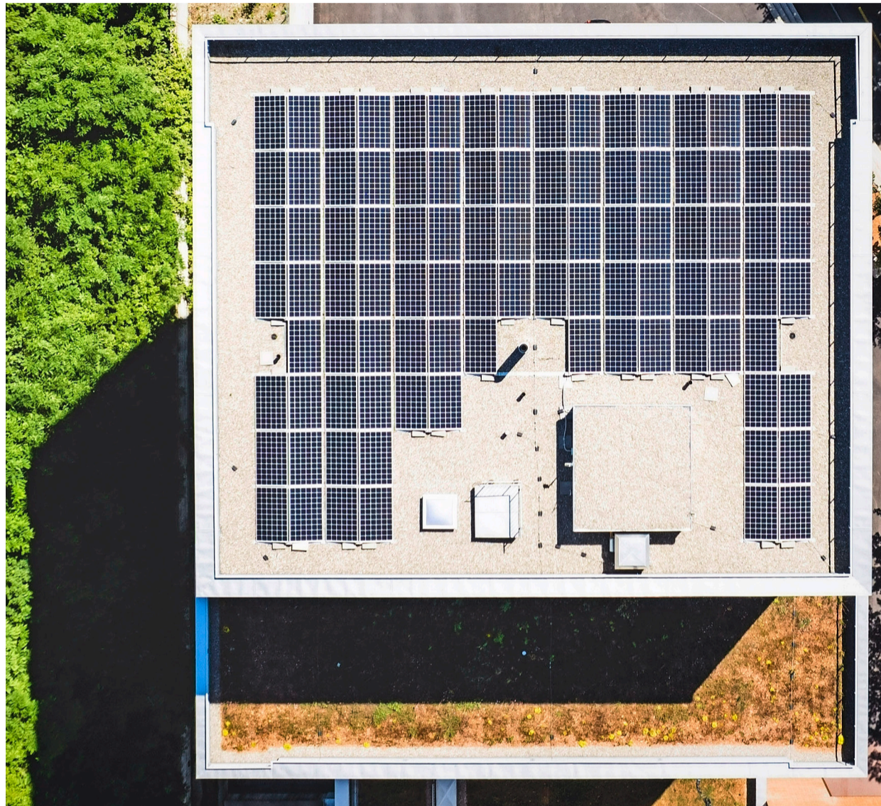
Solarstrom wird von Elektrizitätswerken wie EKS oder SH Power gefördert.
