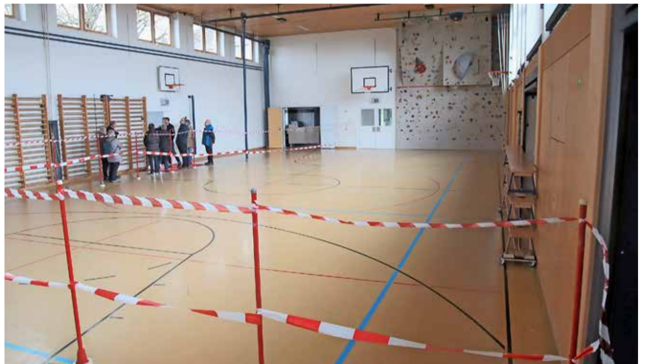
Die 1962 erbaute und zwischen 1984 und 1986 renovierte Uhwieser Turnhalle entspricht nicht mehr den Anforderungen eines zeitgemässen Turnbetriebs. Bei mehreren Rundgängen wurden am Samstag die Mängel an der Halle aufgezeigt. BILD ROLAND MÜLLER
