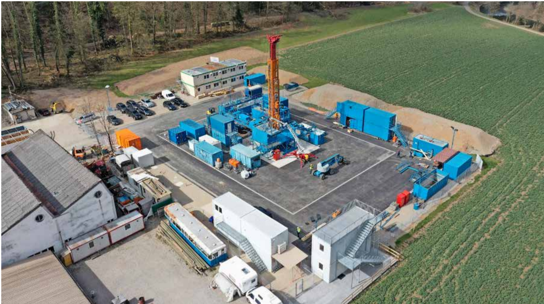
Die Tiefenbohrungen – hier der frühere Bohrplatz bei Bülach – sind praktisch abgeschlossen. Die Nagra wird sich demnächst des Standortvergleichs annehmen.
