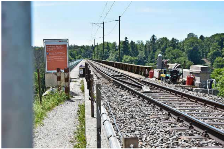
Ab Ende Juli wieder per Zug befahrbar: Die Thurbrücke zwischen Ossingen und Thalheim an der Thur.
