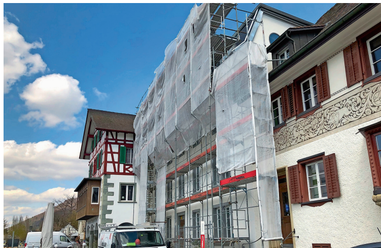
Das wegen Umbau noch verhüllte Haus zur «Rheinschau» zwischen dem Hotel Rheingerbe und dem Haus «zur Gerwe». Bild Mark Schiesser
