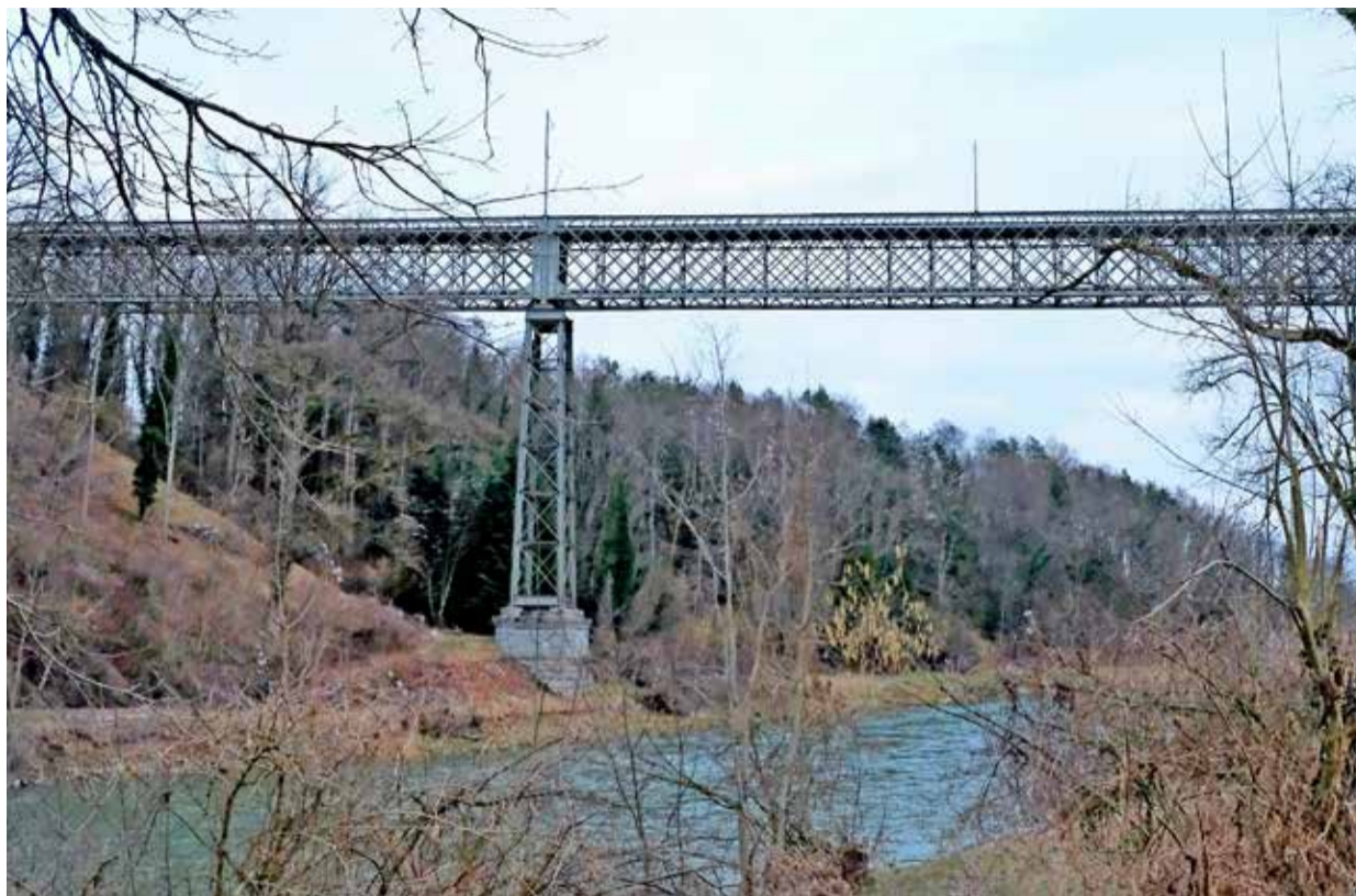
Die Thurbrücke südlich von Ossingen, auf der Zugstrecke zwischen Stein am Rhein und Winterthur.
