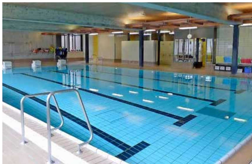
Nach 50 Jahren Betrieb sanierungsbedürftig: Das Lehrschwimmbecken im Innern des Schulhauses «Tanneväg» in Rafz.
