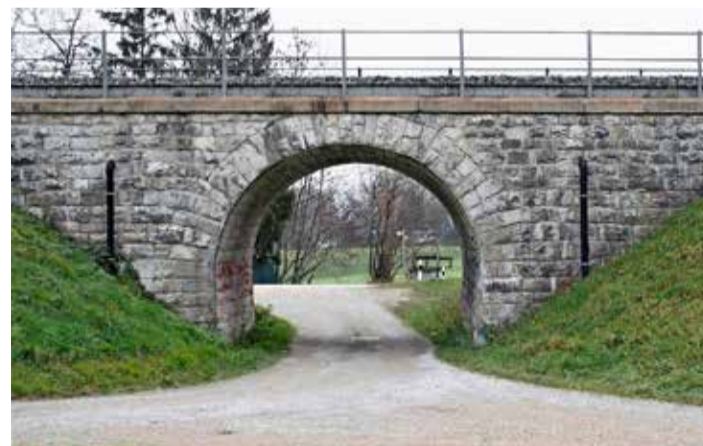
Unter der Bahn soll die Leitung in einem Graben verlaufen.
