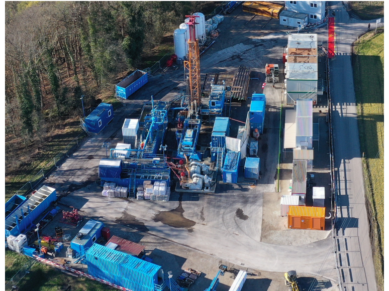
Der Bohrplatz in Marthalen: Hier wurden Gesteinsproben entnommen, um die Beschaffenheit des Opalinustons zu untersuchen. Bild: Nagra
