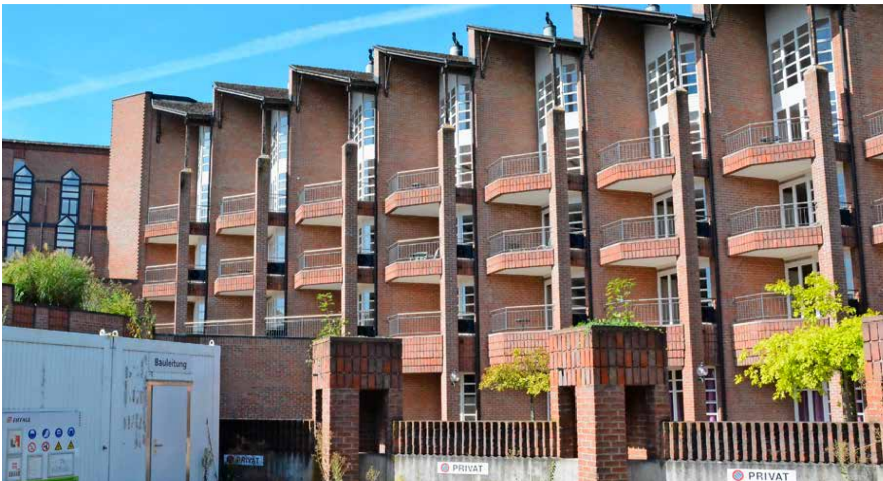
Für den Umbau des früheren Hotels Klosterhof in Stein am Rhein wurde ein neues Baugesuch gestellt.
