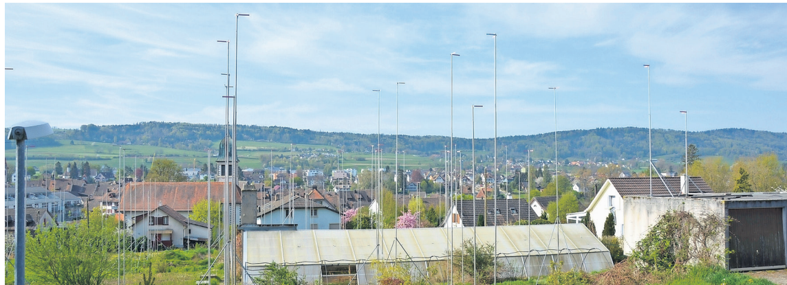
Die Bauvisiere (Aufnahme vom April) des Bauvorhabens auf dem Stoll-Areal.
