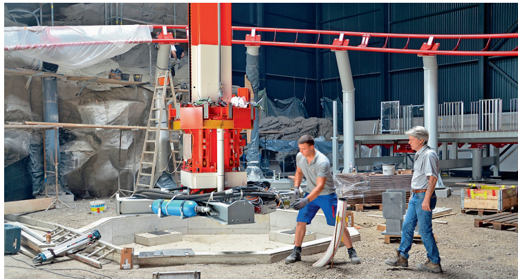
Der «Freifallturm» wird im Zentrum der Achterbahn verankert.
