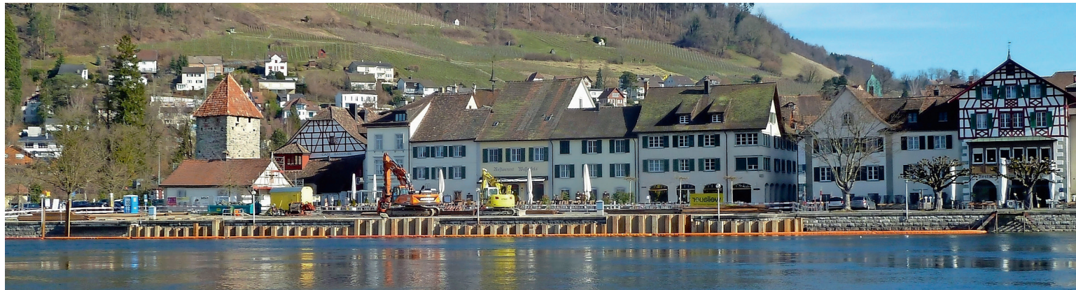
Nach zähem Ringen im Einwohnerrat ist die Neugestaltung der Steiner Schiffände seit Ende November in vollem Gange.
