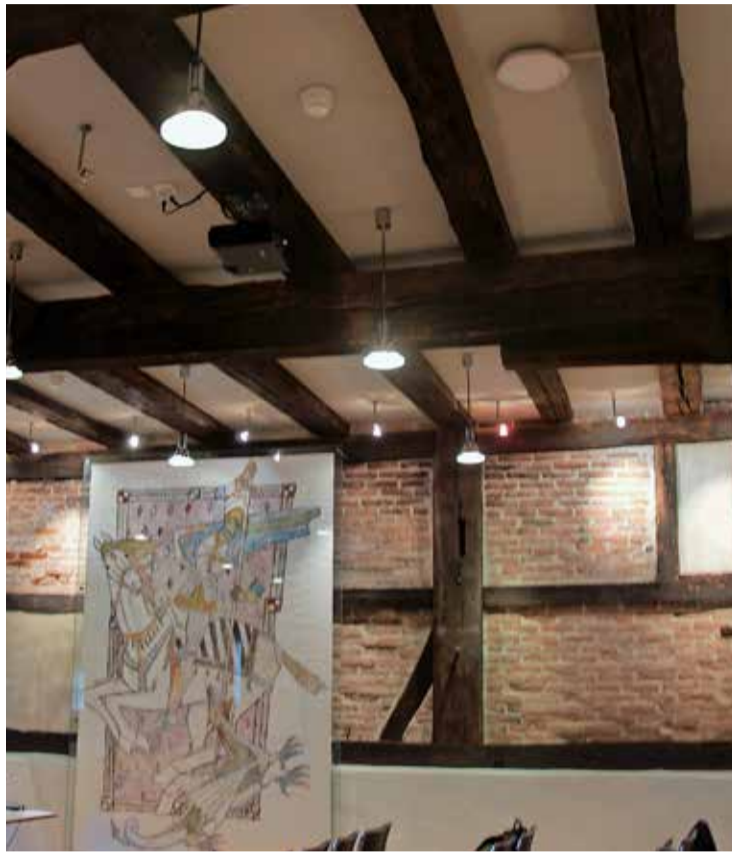
Das Holzgerüst macht den Windler-Saal stabil bei Erdbeben.
