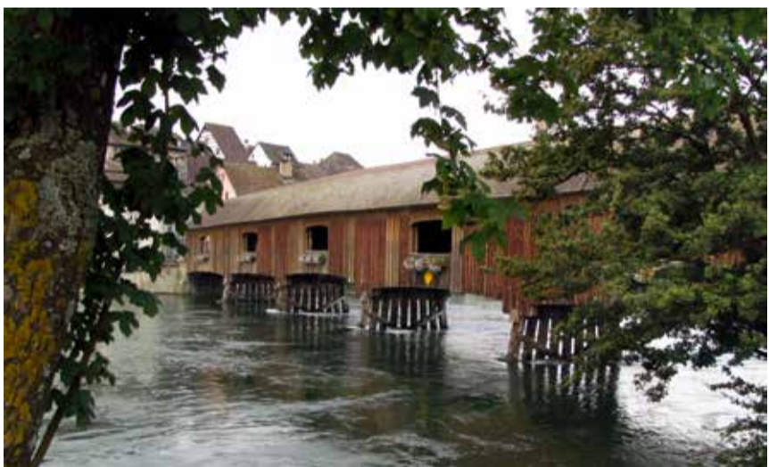
200 Jahre alt: Die Diessenhofer Rheinbrücke ist die letzte Holzbrücke am Oberrhein. Bild ehu
