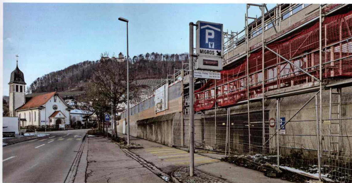
An der Grossi Schanz entstehen neue Wohnungen und öffentlich zugängliche Parkplätze.
