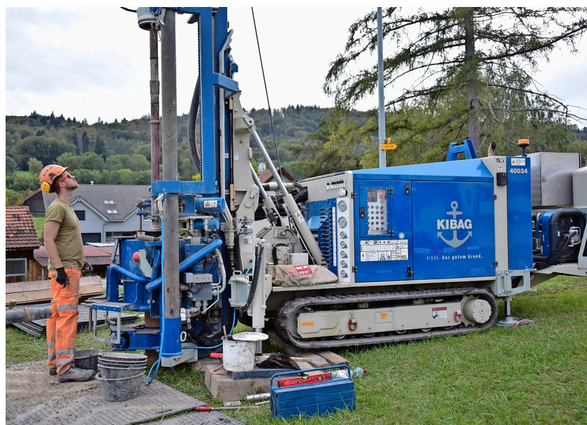
Breit, um auf Raupen vorwärtszukommen. Hoch, um in die Tiefe zu bohren. BILD JVA
