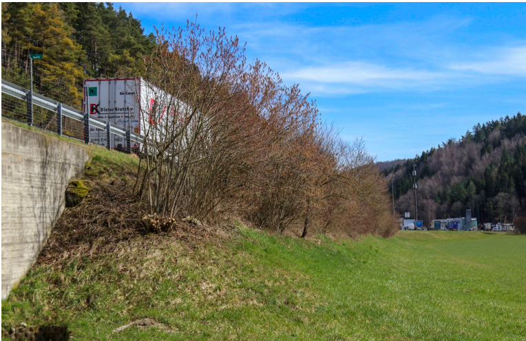
Darum wird gestritten: Hecke an der H4-Böschung.
