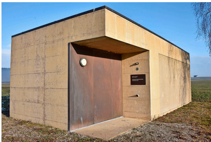
Beim Grundwasserpumpwerk in Etwilwil müssen noch Schutzzonen ausgeschieden werden.
