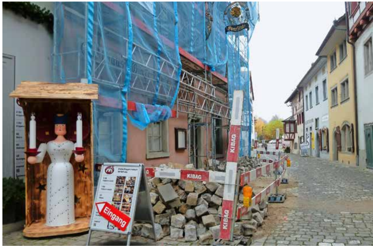
Von den Bauarbeiten an der «Oberen Stube» gingen in den vergangenen Wochen Lärm und Erschütterungen aus. BILD U. JUNKER
