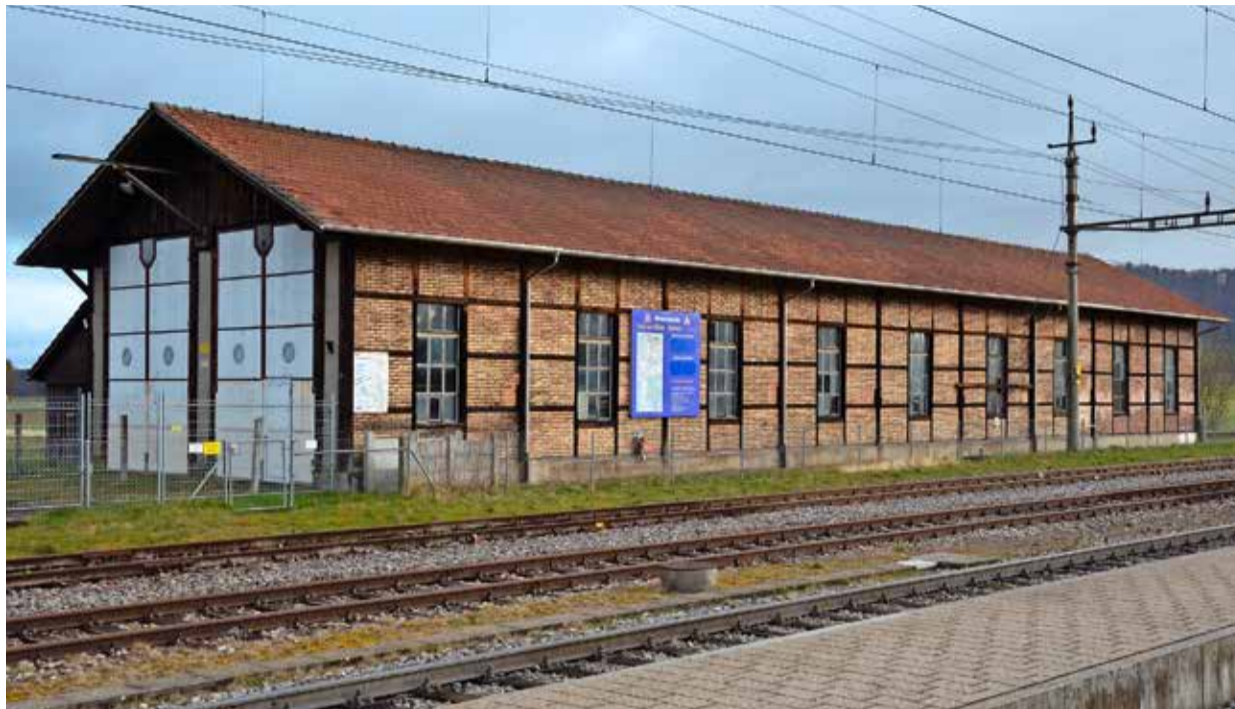
Der Remiseschuppen beim Bahnhof Etwilen gilt im revidierten Schutzplan neu als wertvoll.
