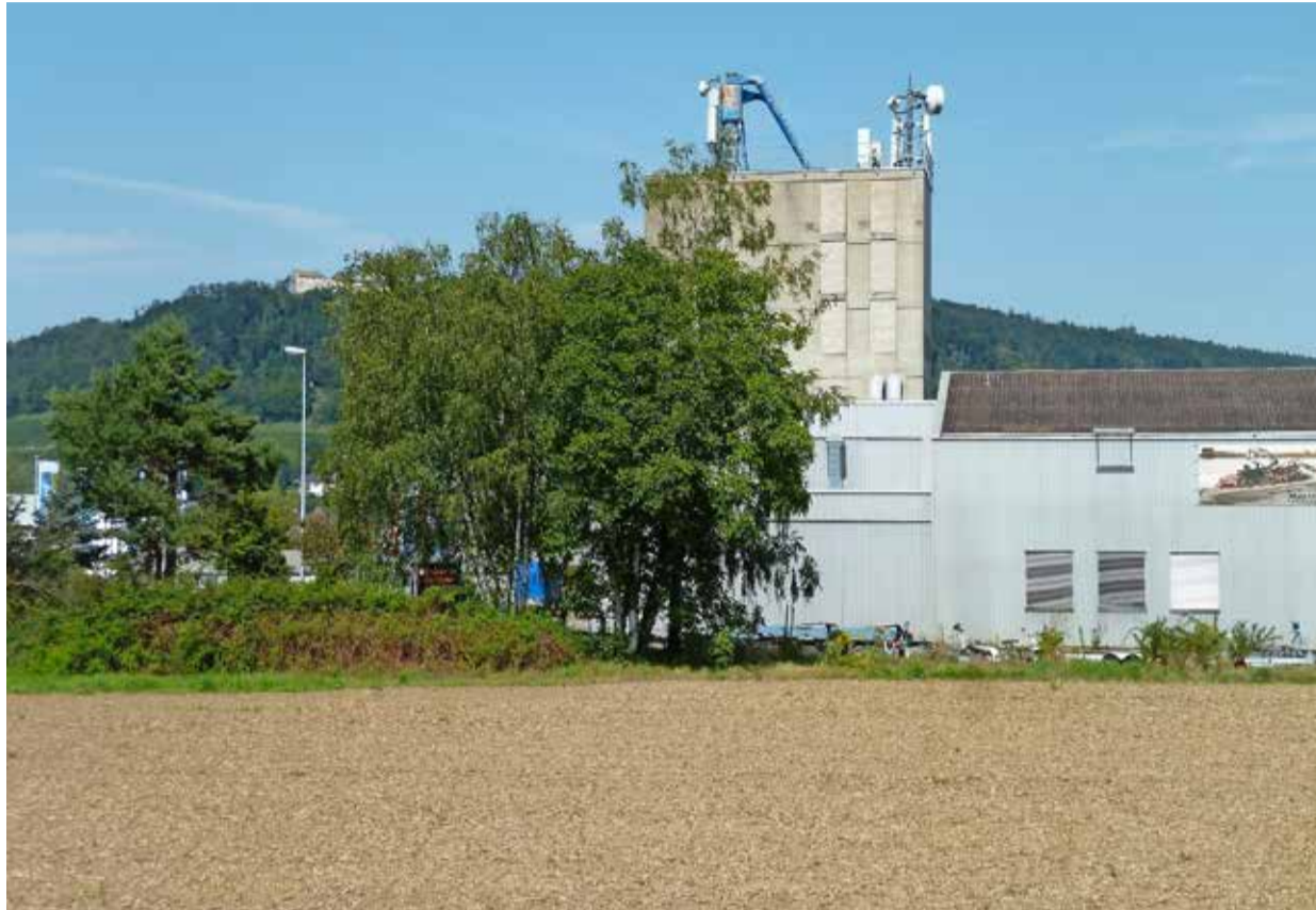
An der Kaltenbacherstrasse in Stein am Rhein steht bereits eine 5G-Antenne.
